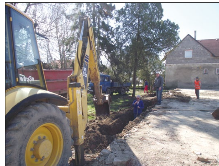
Utorok 16. apríl bol deň, kedy sa začali kopat základy obecnej bytovky pri pamätníku.
