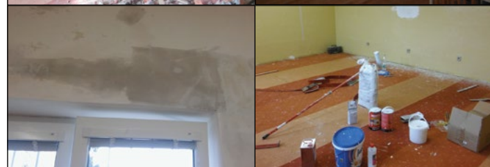
Obecný úrad dal zrekonštruovať miestnosť, ktorú obýva Klub seniorov. Miestnosť sa vymaľovala a povytŕhala sa plesnivá drevená podlaha, ktorá sa nahradila PVC podlahou. Klub seniorov sa už môže stretávať v čistom prostredí.
