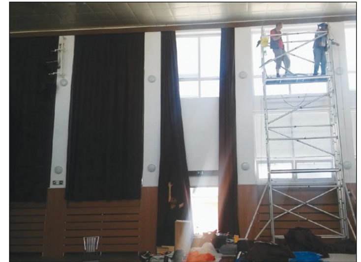
Vo štvrtok 4. júna sa nainštalovali do kultúrneho domu nové závesy, ktoré poslúžia na celkové zatemnenie sály, zlepšia akustiku, zútulnia priestor pri jednotlivých podujatiach a v neposlednom rade sa už ľudia nebudú cítiť ako v skleníku.
