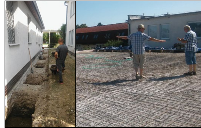
Koncom júna sa začalo s nadstavbou materskej školy. Dokončená bude v decembri.
