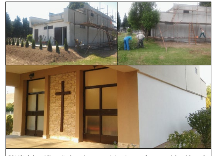
V júli dokončili naši obecní pracovníci práce na dome smútku. Na rade bolo odizolovanie, fasáda a oprava chodníka za domom smútku, kde sa aj vyrezali staré kríky a nasadili tuje na ohraničenie kontajnera na odpad.
