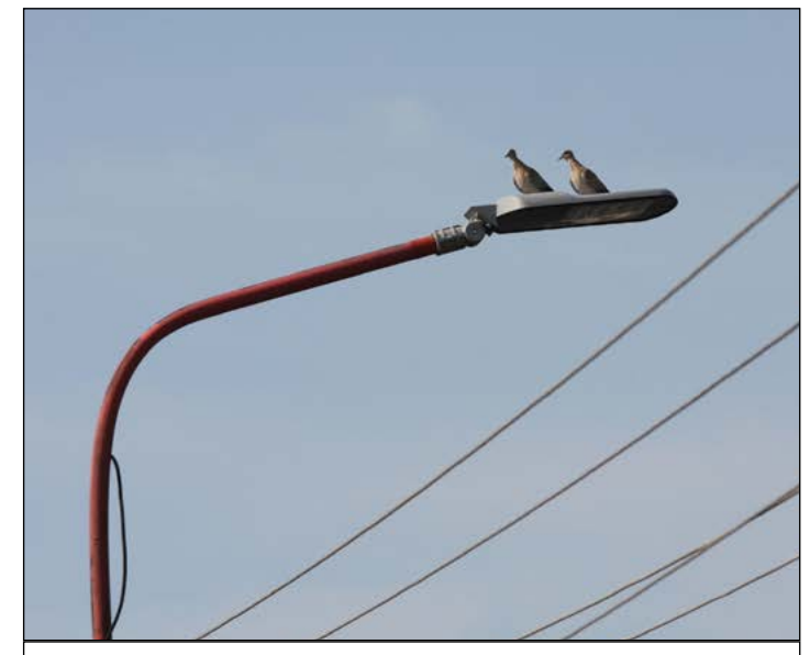
Vo štvrtok 4. júla sa nainštalovalo prvé svetidlo nového verejného osvetlenia – celá dedina vrátane Voderád a Majera bude hotová za dva až tri mesiace.
