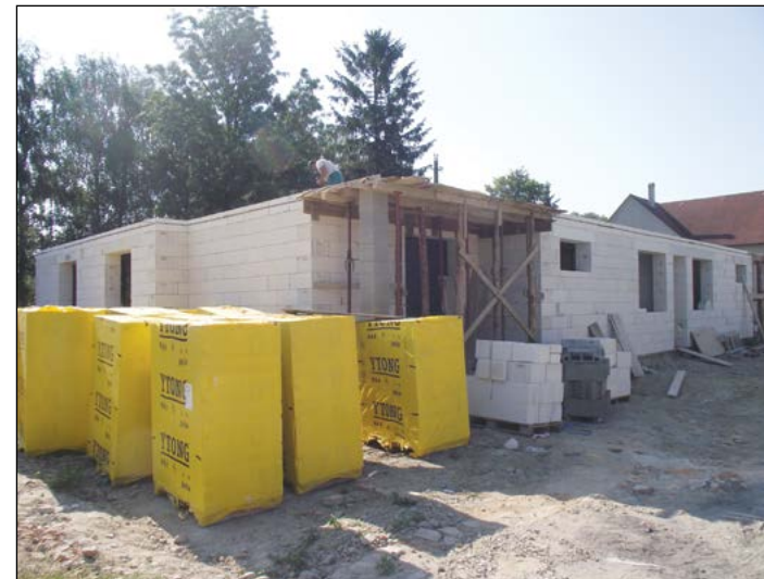
Prosíme občanov o zhovievavosť pri stavaní obecnej bytovky – plán ukončenie stavby - začiatok roka 2014
