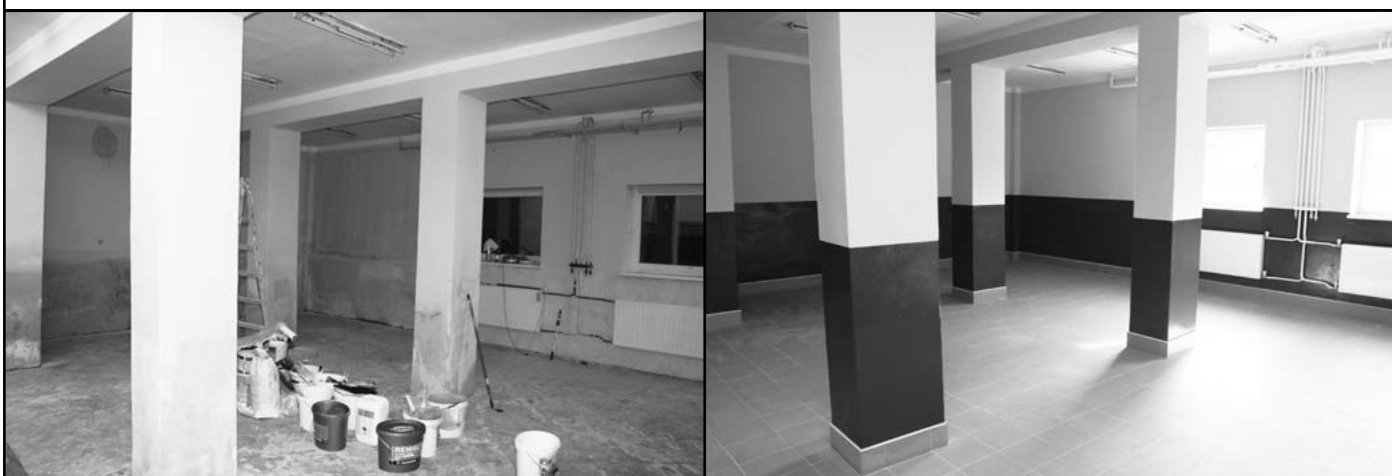
Rekonštrukcia časti „peklo“, budúca výdajňa stravy.
