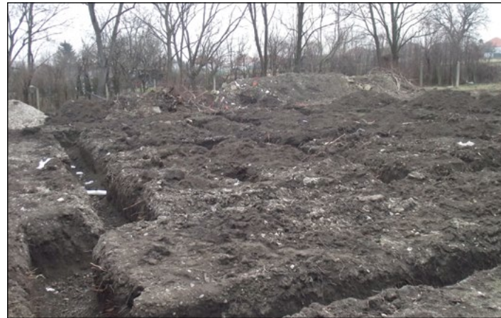
Koncom novembra uzrel svetlo sveta prvý výkop druhej bytovky. Cez zimné obdobie bola výstavba pozastavená. Dátum dokončenia výstavby a jej skolaudovanie je naplánované na koniec roka 2015.
